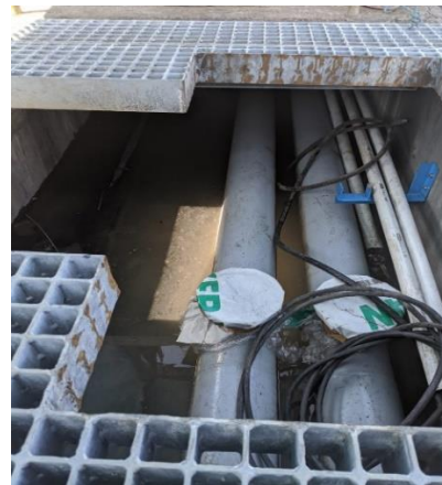
Gambar 1 Kondisi Aexisting pipa
