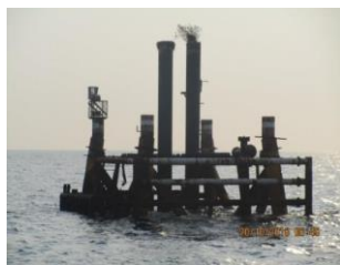
Gambar 1. Anjungan CNOOC yang sudah tidak beroperasi (sumber: Dirtek Migas)
