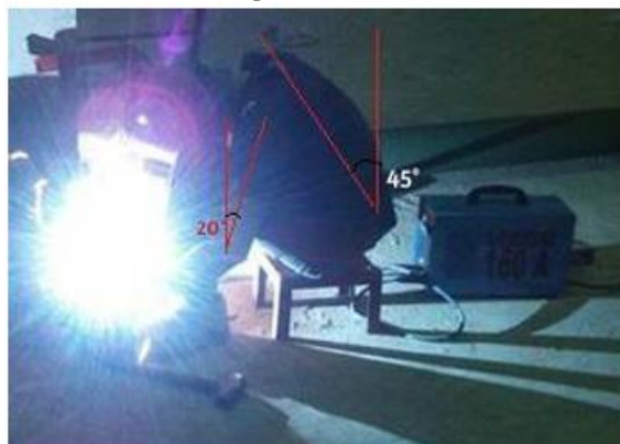
Gambar 4. Postur pada penyambungan besi pondasi
