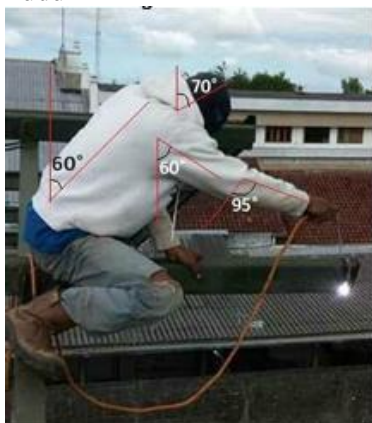
Gambar 3. Aktivitas kerja pengelasan atap bangunan
