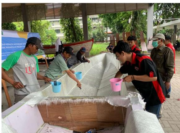
Gambar 6. Laminasi Resin pada Cetakan Kapal
