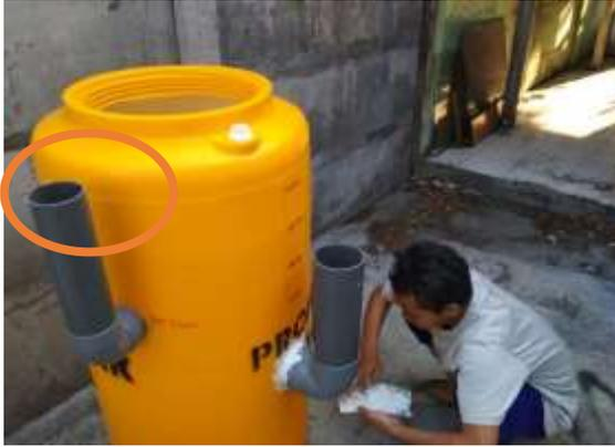
Gambar 10. Proses pembuatan saluran pipa inlet dari digester.
