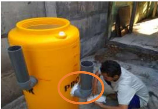
Gambar 11. Proses pembuatan saluran pipa outlet dari digester
