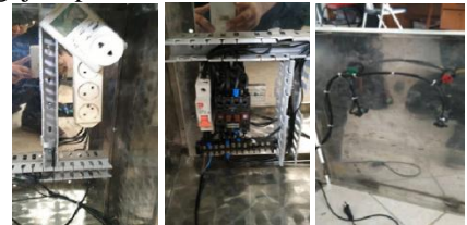
Gambar 3. Jalur Pengaman pada Box Panel
