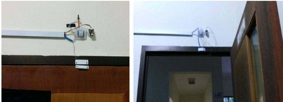
Gambar 3. Instalasi sensor di Ruang Server
