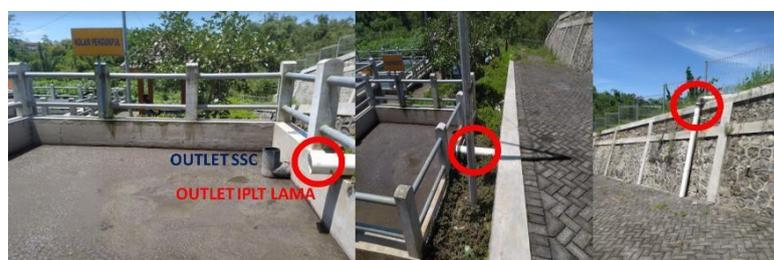
**Gambar 1.** Pipa Saluran Supernatan dari Bangunan Lama IPLT
