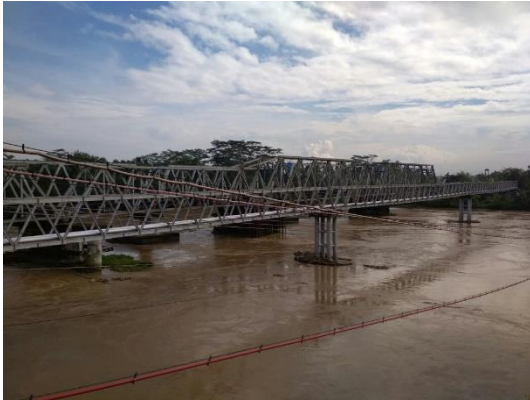
Gambar 1. Jalur pipeline CY2 pada span bridge Sungai Serayu
