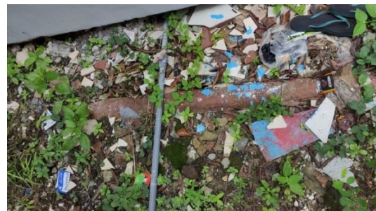
Gambar 2. Dokumentasi Visual Inspection 02-101-A53-4"
