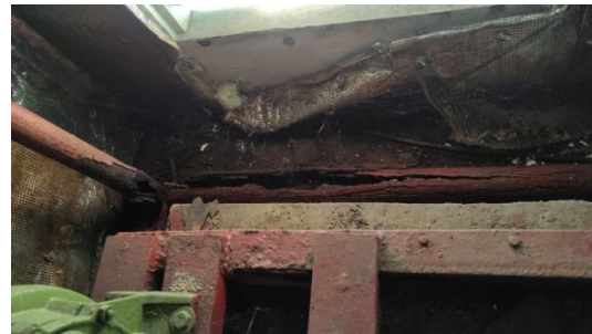
Gambar 1. Dokumentasi Visual Inspection 01-102-A53-3"
